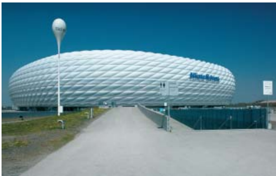
Vestner-Aufzüge transportieren in der Allianz-Arena Fans, VIPs, Spieler, Personal und Stückgut.
